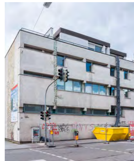
Das ehemalige Gemeindezentrum St. Martin wird umgebaut.
