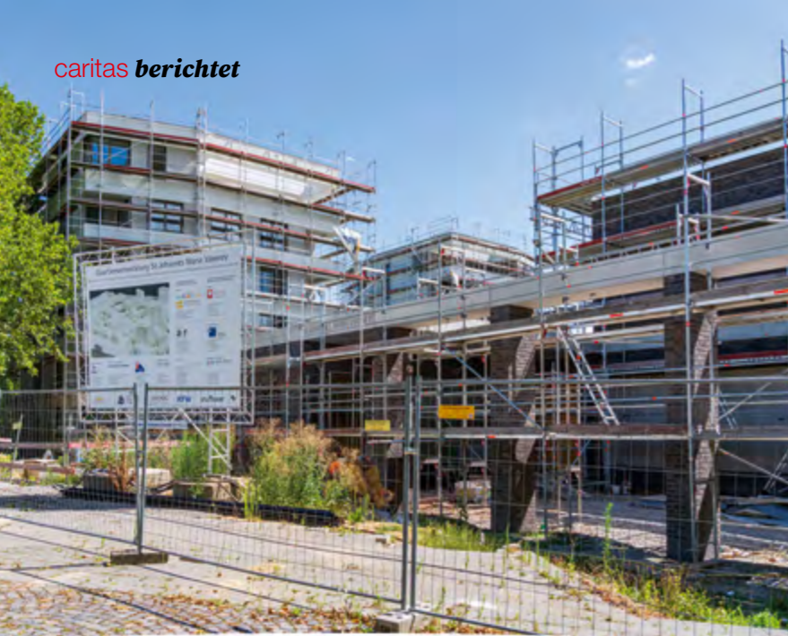
In Mönchfeld entsteht „Wohnen mit Service“
